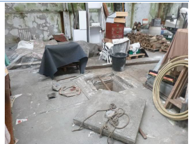
Photo n°5 : Vue sur 1 cuve enterrée de carburants au sein de l'ancien atelier mécanique
